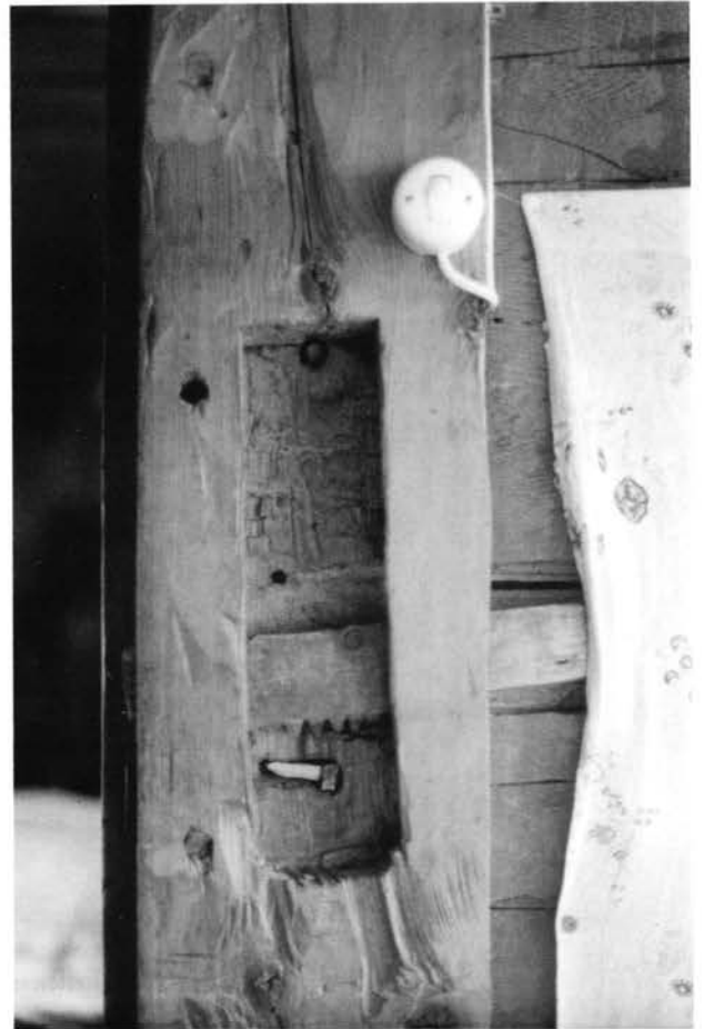
Pl. 35. Verrou à denture vers le bas avec "clé" fixe (à demeure), chalet à La Comballaz.
