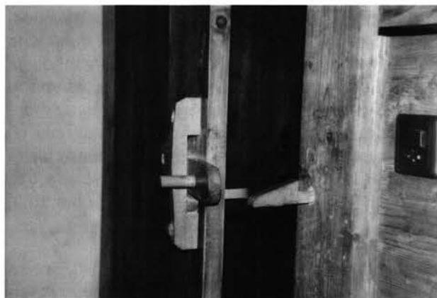
Pl. 17. Loquet de bois avec bouton à excentrique posé lors d'une restauration de chalet à La Forclaz.
