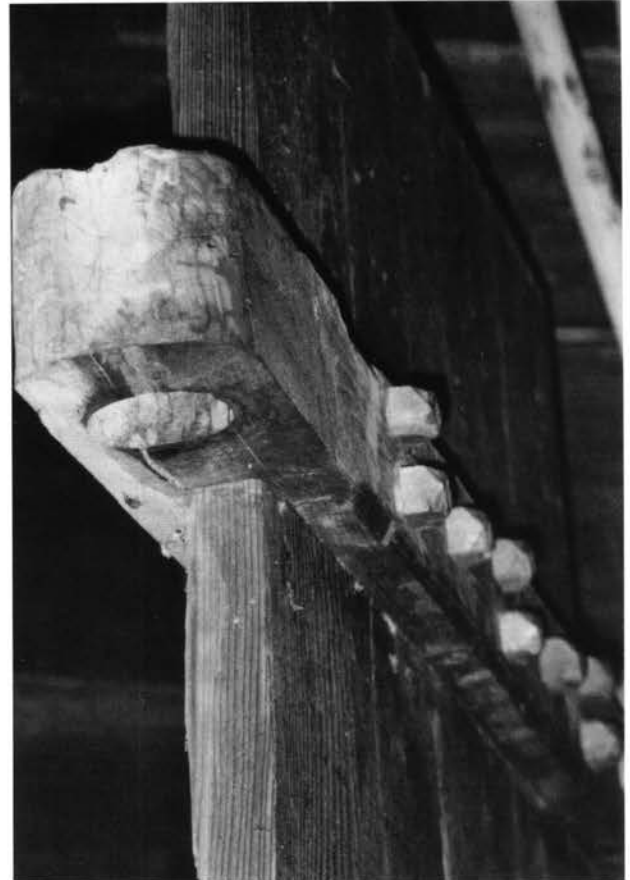
Pl. 6. Porte à pivot au chalet du Crosex (sur Vers-L'Eglise) : le haut de la quenouille pénètre dans le linteau.
