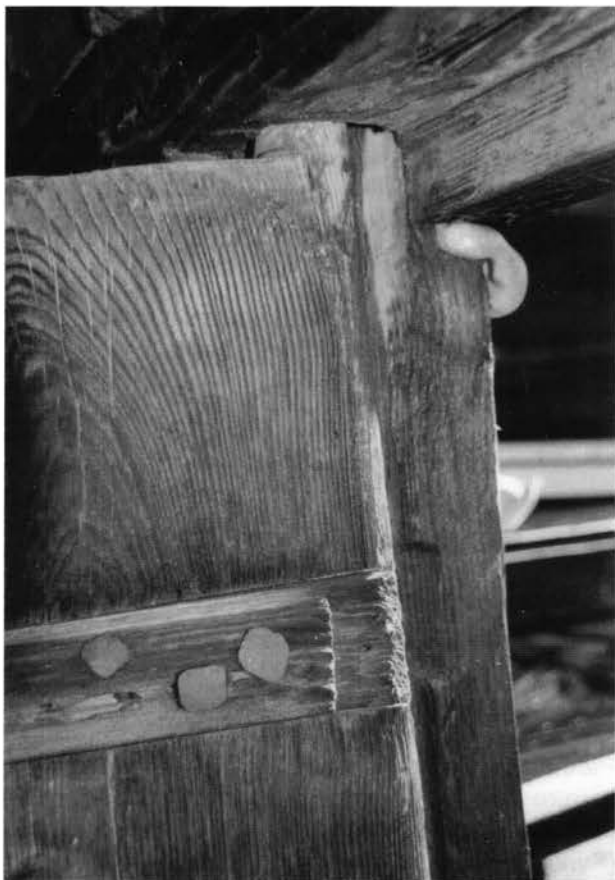
Pl. 3. Porte à pivot au chalet du Crosex (sur Vers-L'Eglise) : le haut de la quenouille pénètre dans le linteau.
