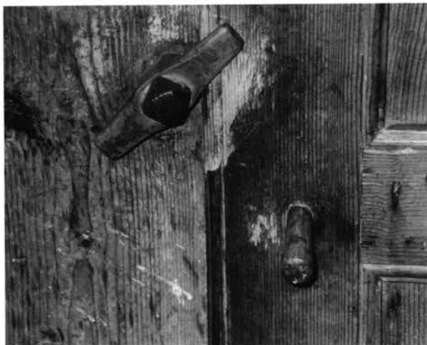
Pl. 14. Cheville tournante à la Forclaz (VD)
