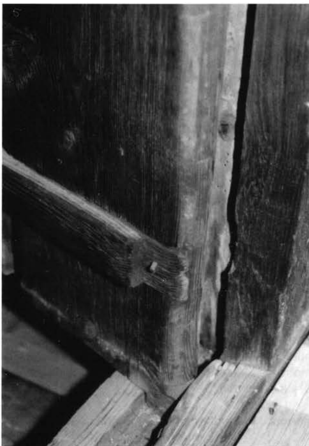
Pl. 4. La même porte : pour la mise en place, il fallait une rainure aménagée dans la poutre de seuil.
