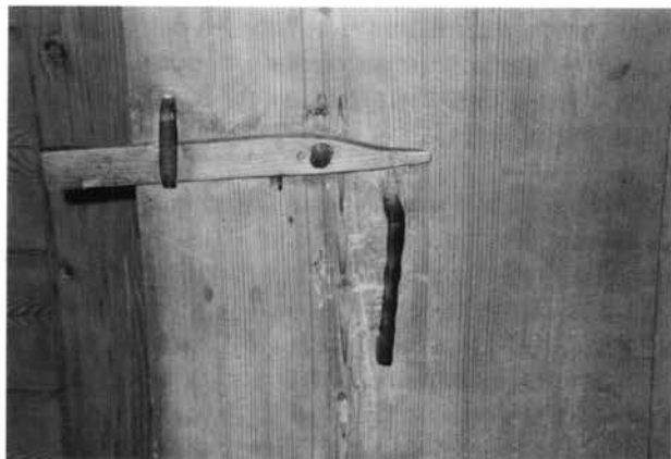
Pl. 16. Loquet de bois simple aux "Béquettes" (Diablerets)
