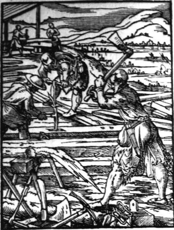
Pl. 5. Jost Amman. Gravure de 1568 montrant le travail des charpentiers et notamment l'un d'eux forant un trou à la tarière, alors qu'un autre creuse une mortaise au piochon.
