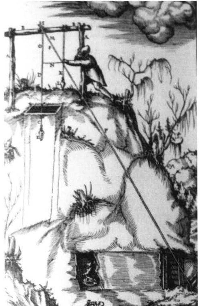
Pl. 94. Georgius Agricola 1556. Utilisation du fil à plomb pour la construction de triangles rectangles et l'application des règles de proportions.
