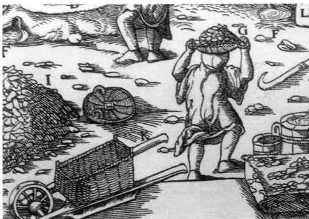
Pl. 2 Au XVI e . siècle, l'industrie métallurgique faisait appel à la vannerie pour le transport du charbon, dans des sortes de vans qu'on portait sur la tête, ou dans des brouettes dont la caisse était en vannerie. (Gravure tirée de De re metallica d'Agricola)
