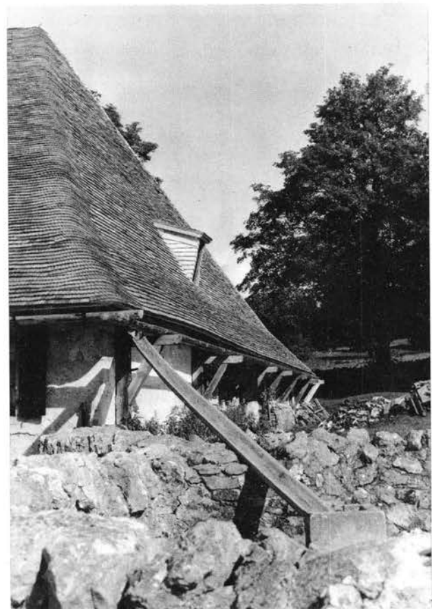
Fig. 2 Provence, chalet d'alpage de la Redalle.
