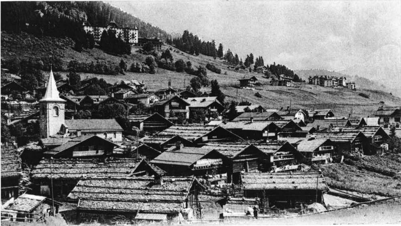
Fig. 5 Leysin avant 1907: les anseilles chargées prédominent encore, quelques toits ont été refaits en tavillons cloués.
