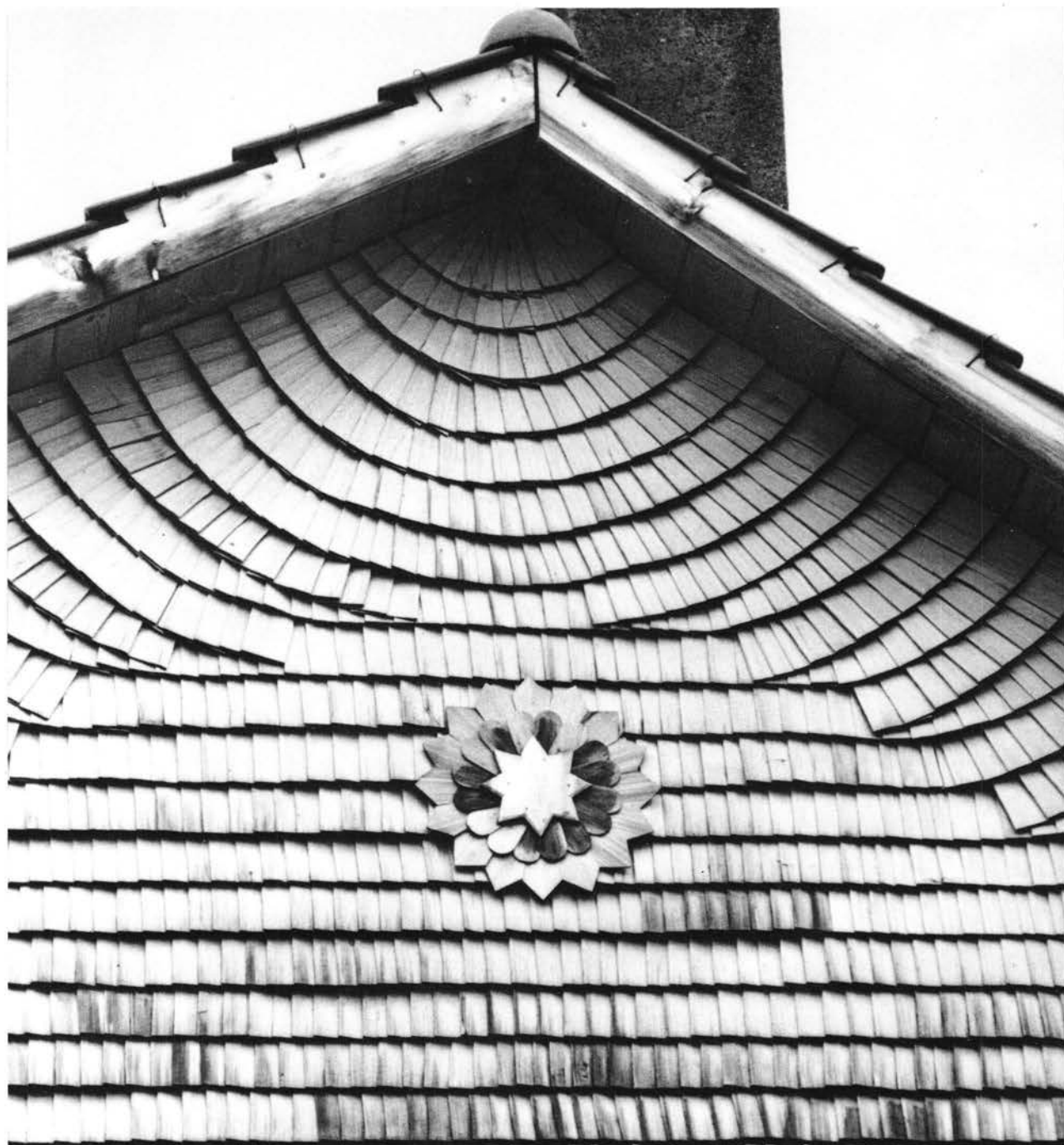
Fig. 35 Sainte-Croix, Village. Soleil sous le pignon.
