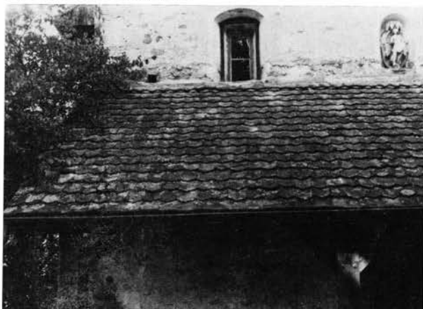
Fig. 4 Thoune: tuiles alignées verticalement, un tavillon posé sous la jointure assure l'étanchéité.
