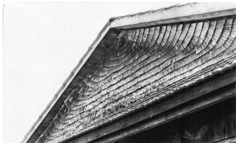
Fig. 32 Provence, lieu-dit « Chez la Gaille », ancienne chape en tavillons, raccord en arrondi sous l'avant-toit.
