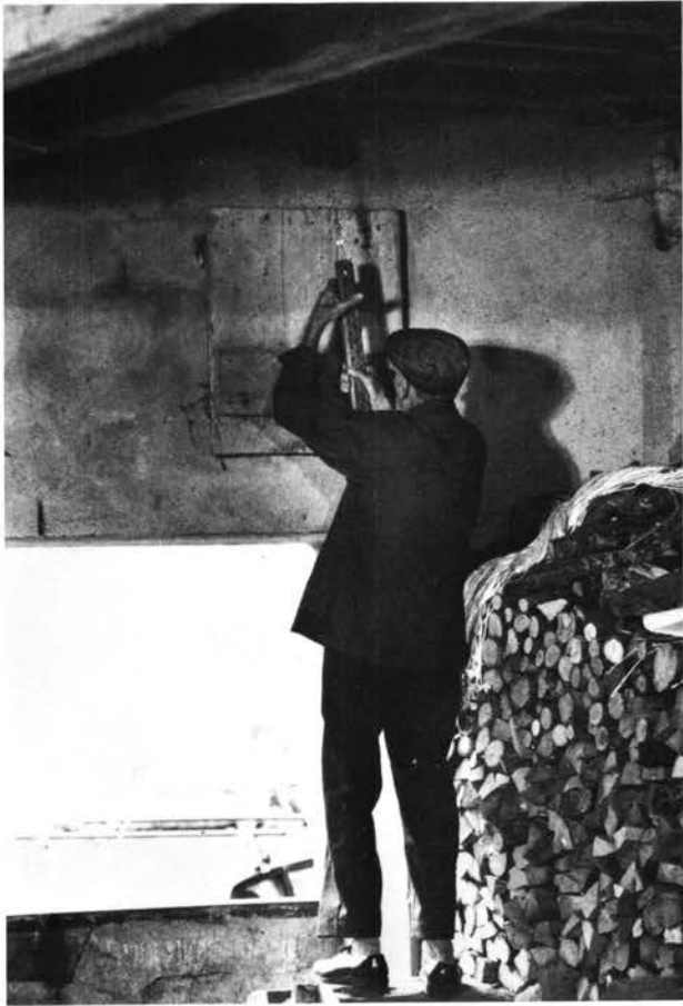
Ouverture de la soupape commandant l'eau à l'entrée de la «chéneau» (canal d'amenée d'eau sur la roue). La planchette est percée de trous qui permettent le «réglage de l'eau» (réglage du débit) et commande par là la vitesse de rotation de la roue à augets.
