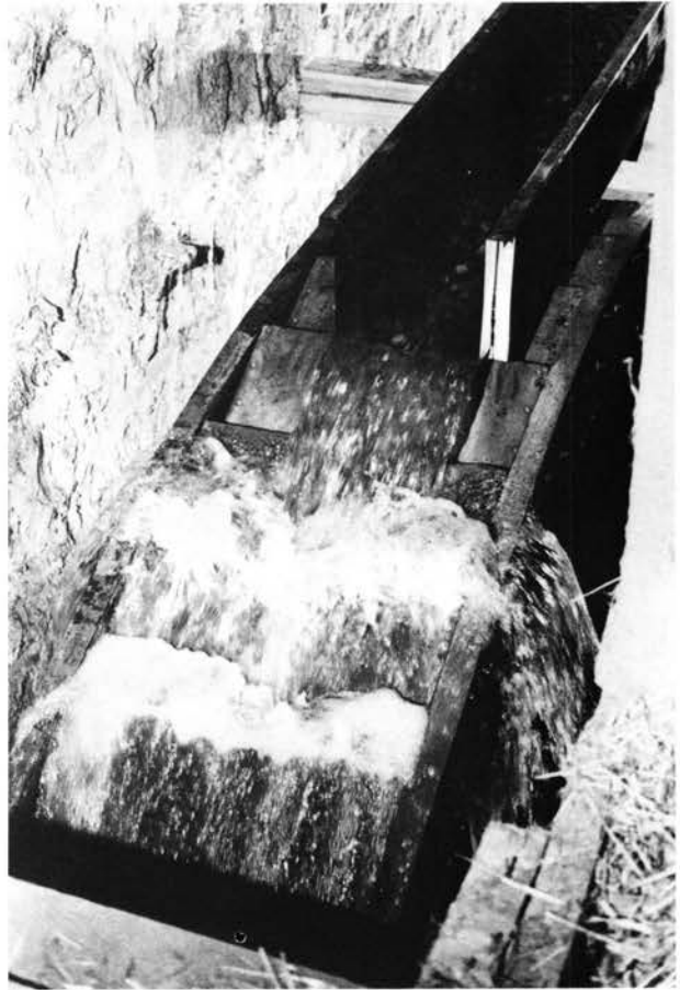
Arrivée de l'eau sur la roue à augets.
