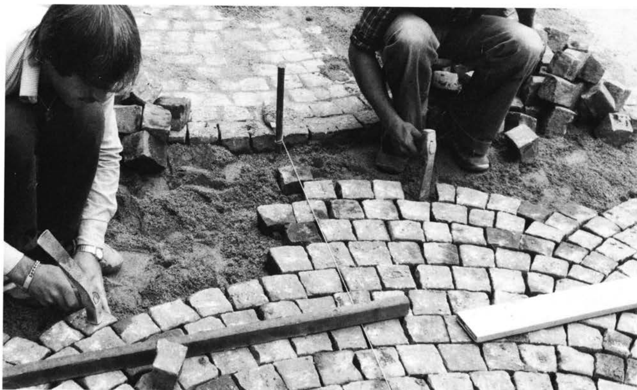
Pl. 24 Poseurs de pavés: les arcs de force sur lit de sable.
