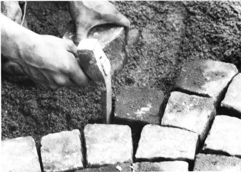
Pl. 25 La panne pour préparer la loge du pavé dans le sable.
