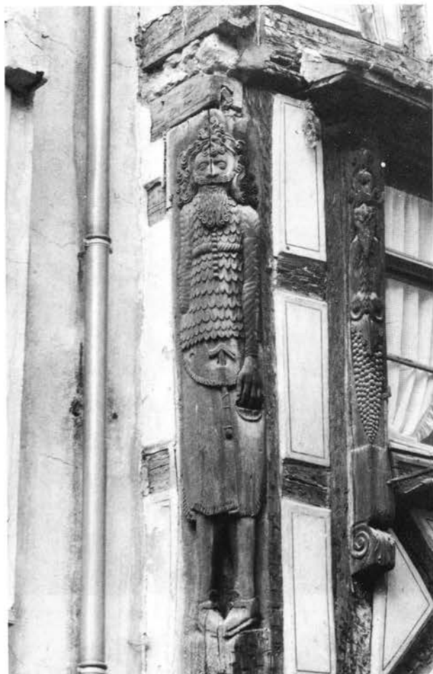
Pl. 28 Poutre d'angle à Riquewihir: un maître charpentier du début du XVII e siècle...
