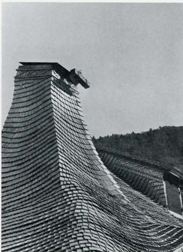
Pl. 20 Toit de tavillons. Chalet de la Grande-Bonnaveau, propriété de la Commune de La Tour-de-Peilz.
