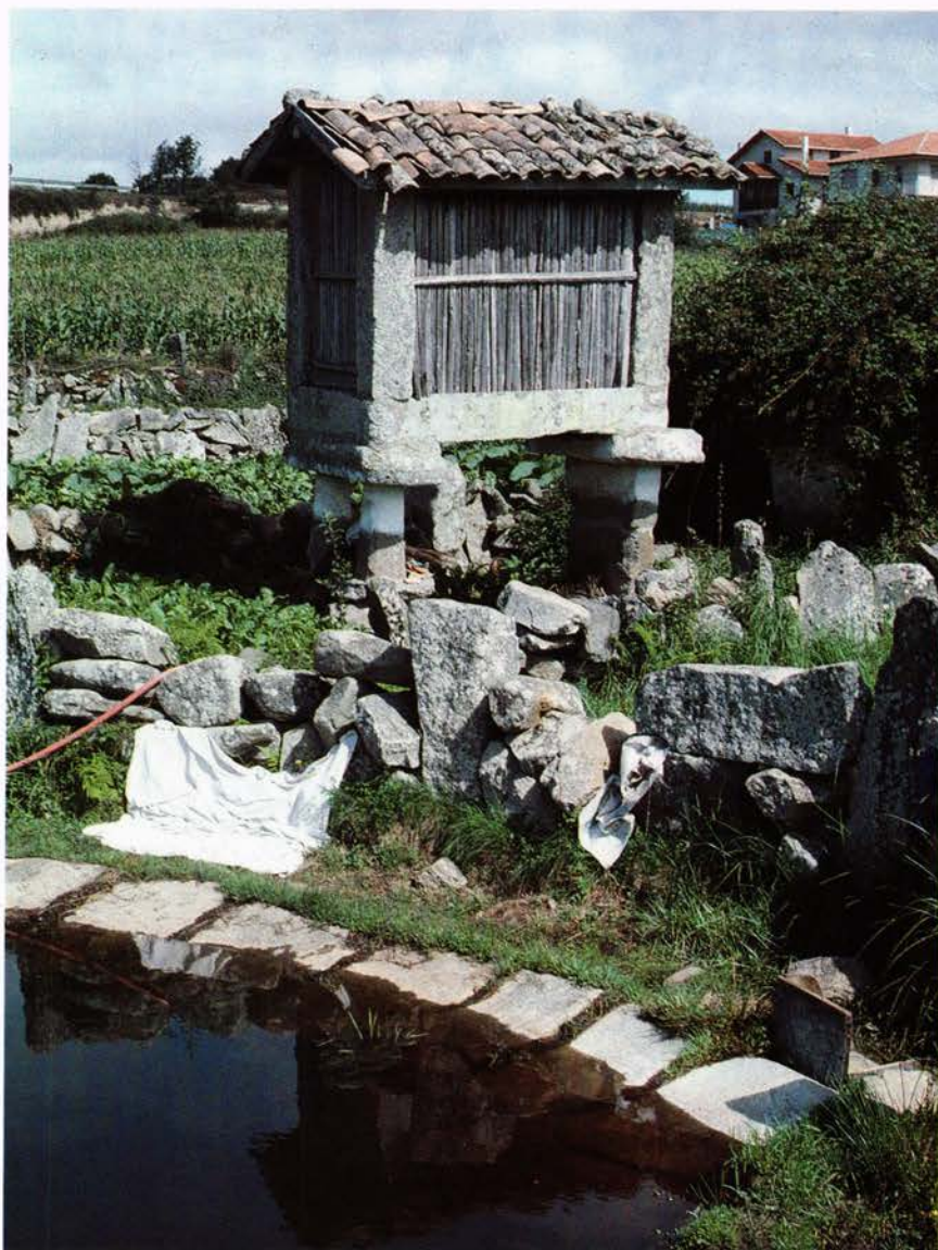
Fig. 3 Grenier espagnol sur pilotis de pierre pour mettre le maïs à l'abri des rongeurs.
