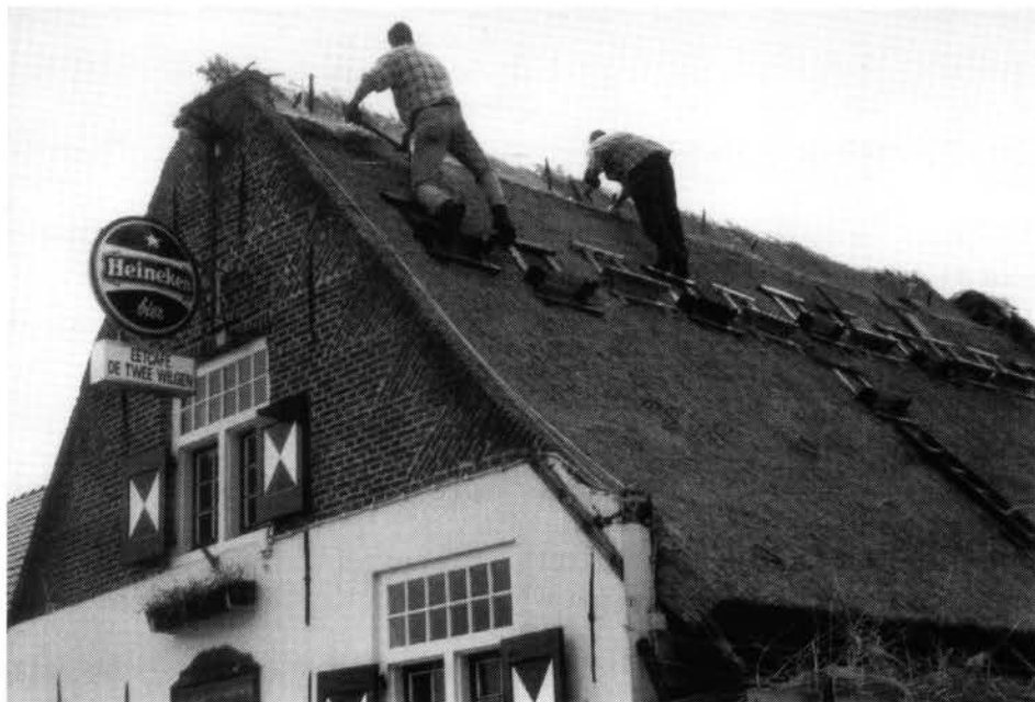
Un métier qui se perd: la réfection d'un toit de chaume.
