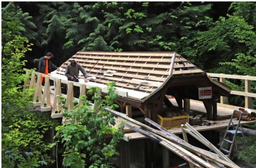
Remplacement des tavillons sur le toit de la Passerelle de la Sandoleyre.
